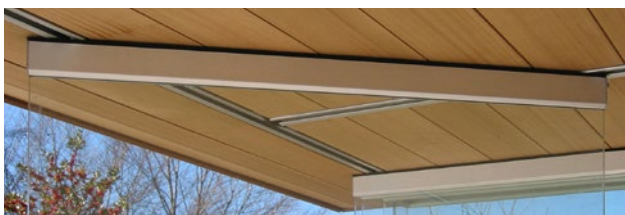
Bahnhof integriert in Decke
