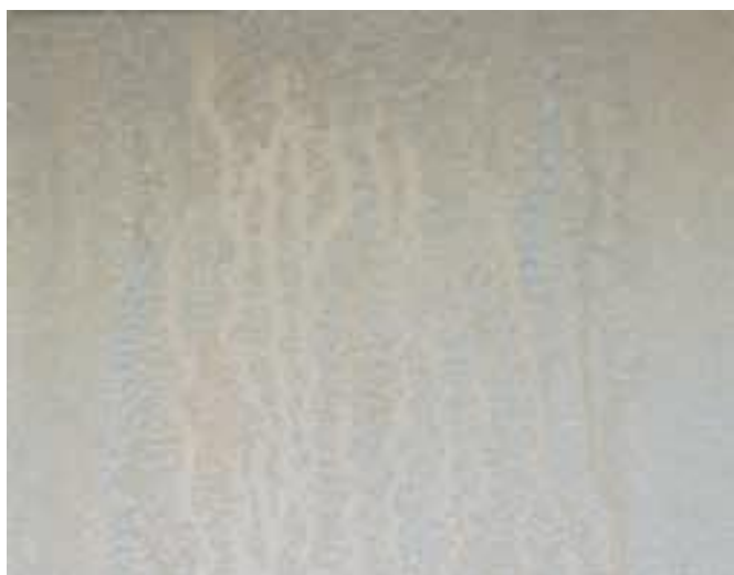
Klares Standardfloatglas - sichtbare Korrosion
